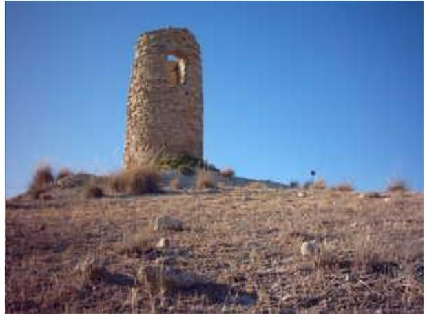
Tiene planta circular de 3,64 metros de diámetro y aproximadamente 7 metros de altura. Conserva prácticamente toda su estructura, faltando solo la terraza y el parapeto superior. Está
