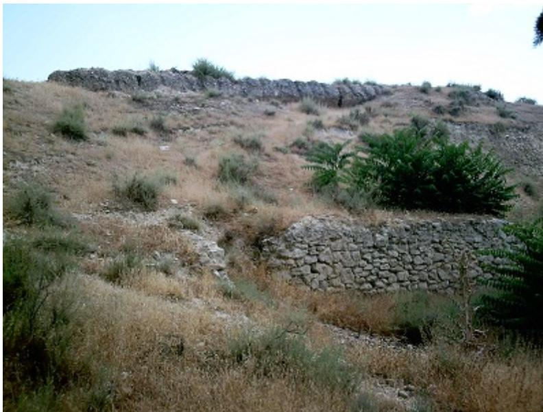
En la intersección de la muralla norte con la torre del homenaje se pueden ver restos de otras construcciones que conforman un espacio de dimensiones 9 x 6 metros, con las esquinas reforzadas con sillería y que, por su estructura, podría tratarse del complejo defensivo de la puerta de acceso.
